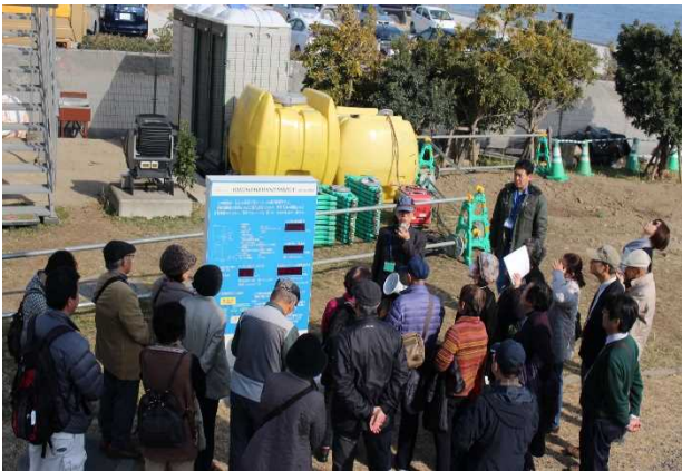
ハマウイング見学・説明（まわり工事中）
